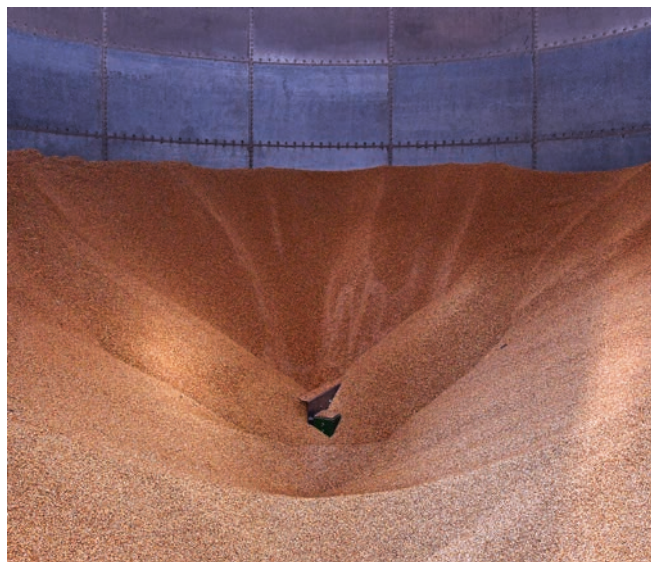
Tidligere var de to siloer gastætte. I dag er de ændret til beluftnings-siloer, der fyldes 3-4 gange årligt med lagerfast korn.
